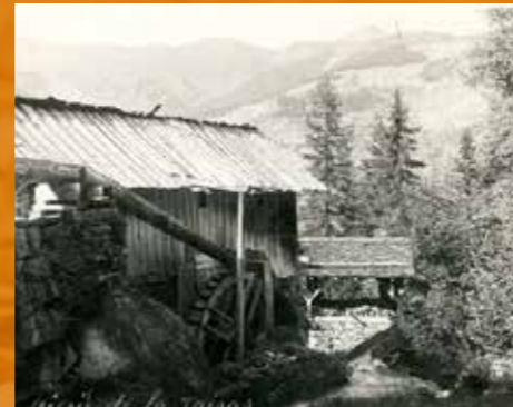
La scierie dans les années 1930 avec sa roue à augets mise en mouvement par l'eau du torrent, premier maillon du système d'entraînement de la mécanique.
