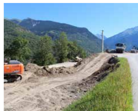
Travaux du parking du Fontanil
