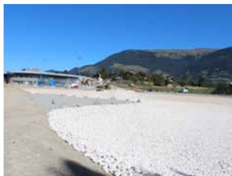
Les aménagements des abords du lac du Praz : le fond du lac est recouvert d'un matériau clair
